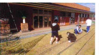
道の駅イルミネーション設置
