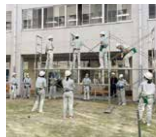
足場組立実習
