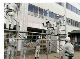
足場組立実習
