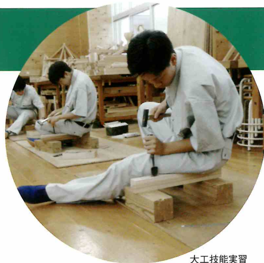
大工技能実習
