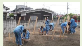
施工実習 (丁張り設置)
