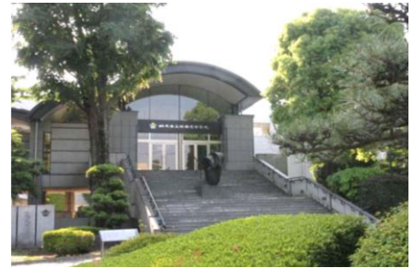
正門から正面玄関を望む
