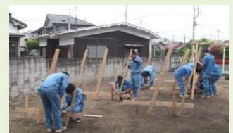
施工実習(丁張り設置)
